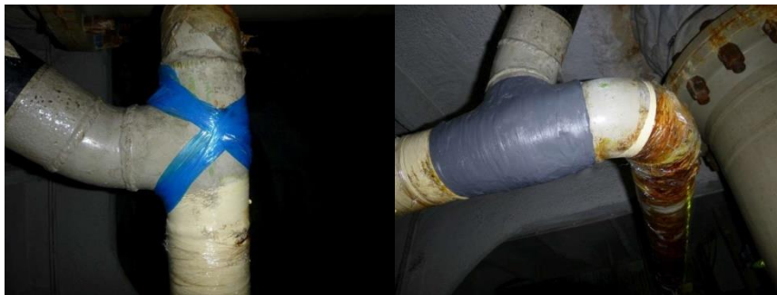
... defekte Wasserleitung: provisorische, oder fachgerechte Reparatur mit ARC 10
