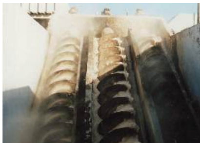
Drei Abwasserpumpen vor der Reparatur in Betrieb
