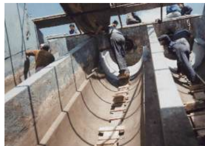
ARC 791 wird auf ordnungsgemäß vorbereitete Oberflächen aufgetragen
