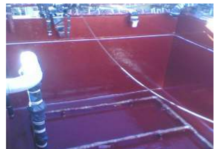
Auftragung der ARC CS4-Deckschicht
