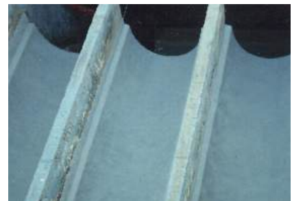
Alle drei Pumpenwannen werden mit ARC 791 beschichtet
