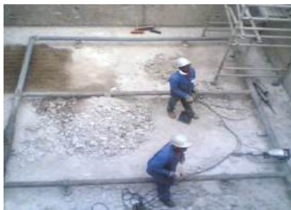
Préparation de la surface
