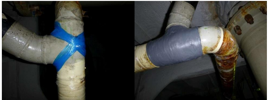
... defekte Wasserleitung: provisorische, oder fachgerechte Reparatur mit ARC 10
